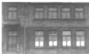
Bo szkolna izba w środku z piwnicą... Dawna elewacja szkoły powszechnej. Fot. www Gimnazjum w Susku.
